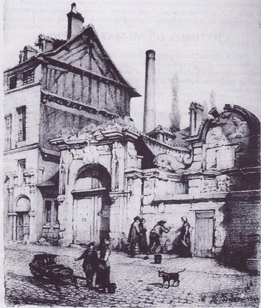
« La fontaine-réservoir des Pénitents », aquarelle de A. Duboc (1864) - (BMR Deglatigny n° 76)
